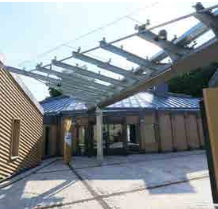
Neues Glasdach über dem Eingangsbereich des Wiking Museums
