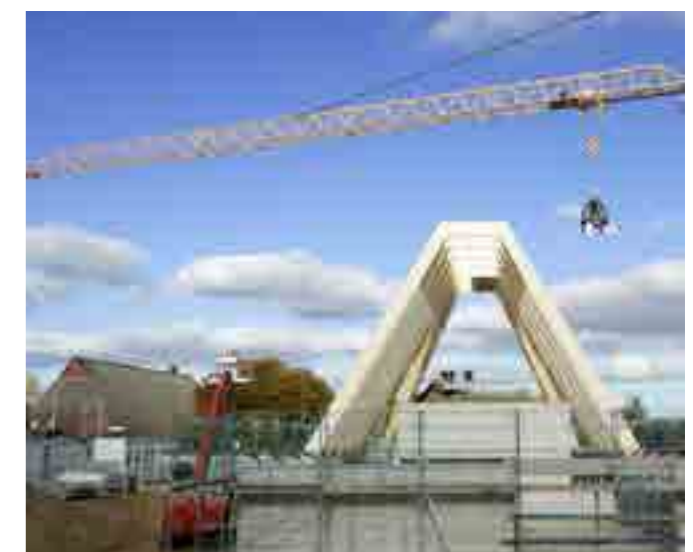
Ende 2020 soll das neue Ausstellungs- und Eingangsgebäude fertig sein.
